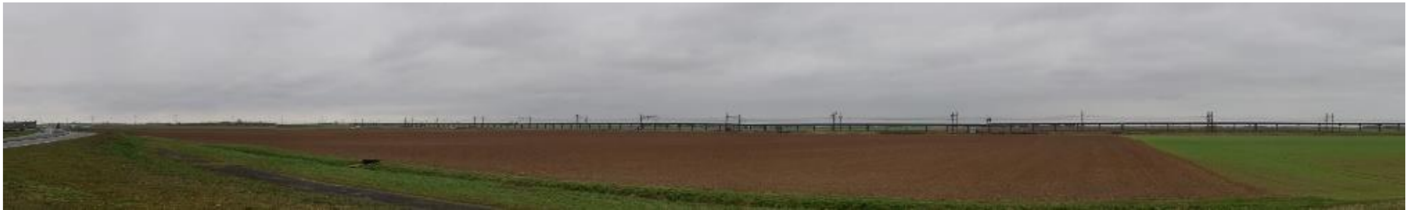
Photographie 24 : Caténares de la voie ferrée et ancienne voie de l'aérotrain
